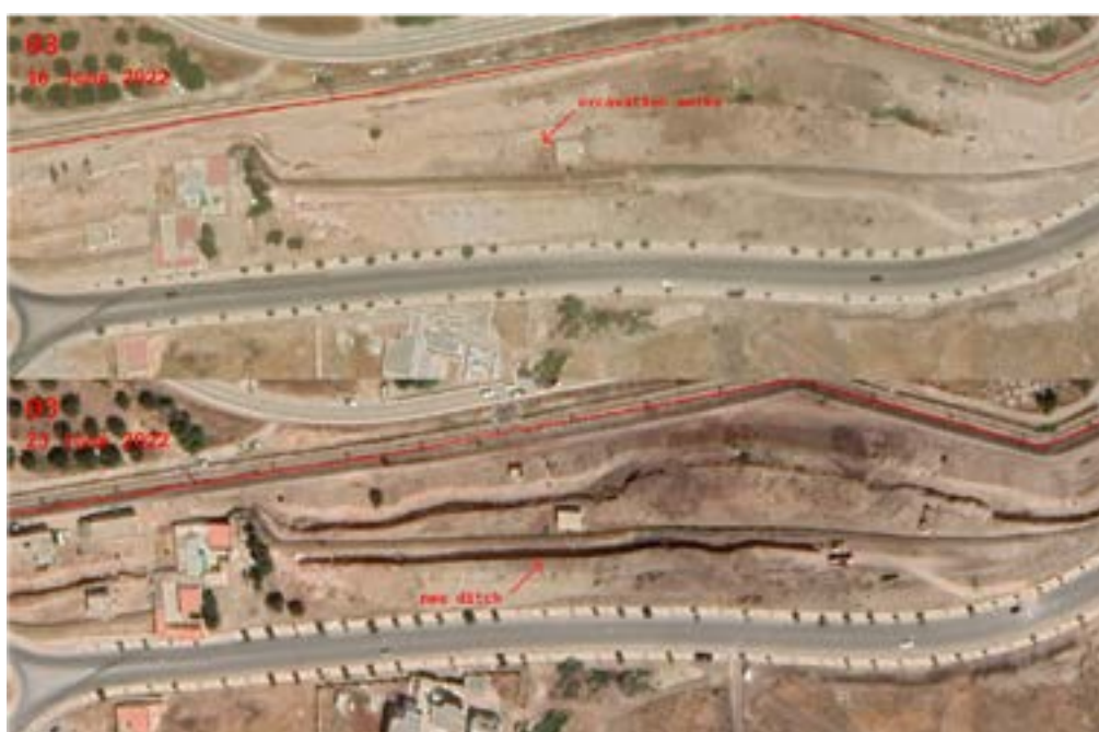
La comparaison entre les images satellites du 16 et du 23 juin 2022 révèle la construction d'une nouvelle tranchée. Image satellite prise à 10:59 UTC le 16 juin 2022 et à 11:09 UTC le 23 juin 2022. Image Google Earth ©2022 Maxar Technologies.
