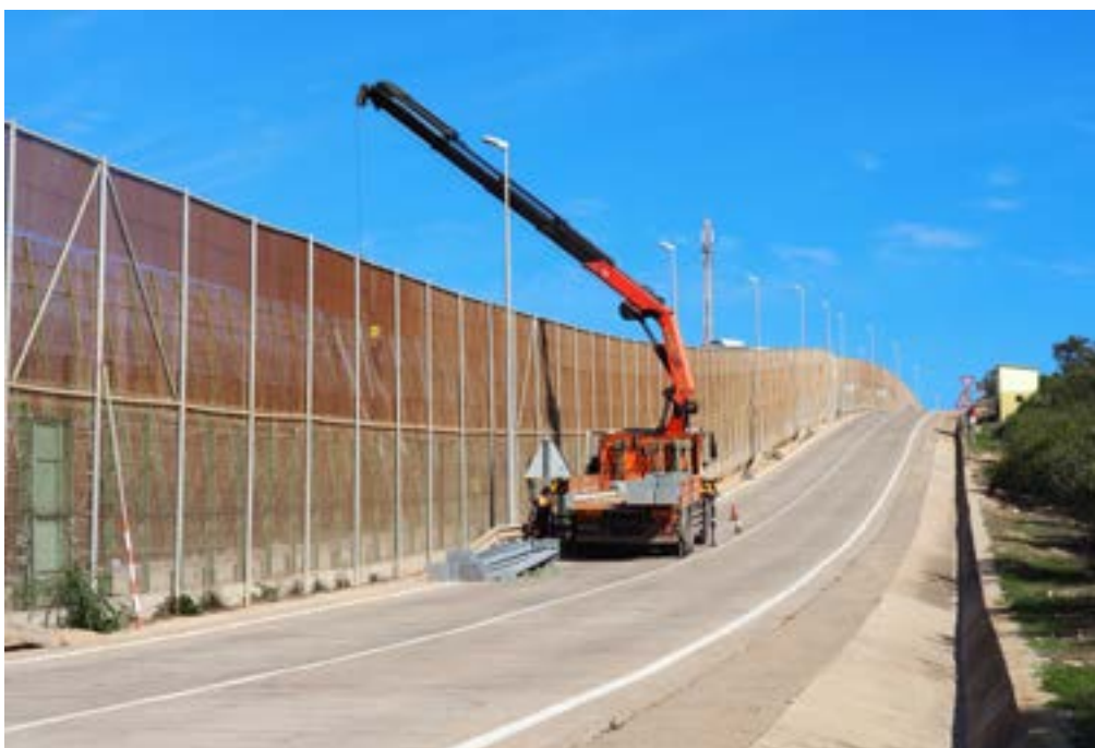
Photographie de la construction continue de la barrière frontalière entourant Melilla. Photographie : Alicia Martínez, janvier 2021.
