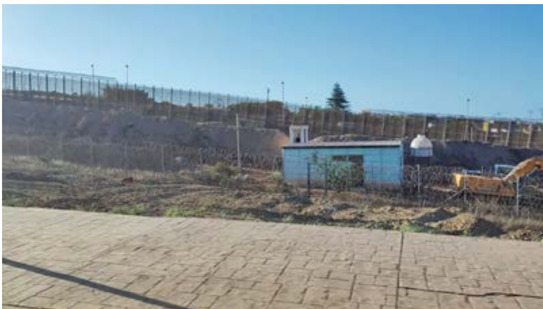
Capture d'écran d'une vidéo de la frontière montrant des machines de construction utilisées pour creuser la tranchée devant la partie de la clôture frontalière qui n'est pas équipée de « peignes inversés ». Vidéo : Alicia Martínez, 26.06.22.
