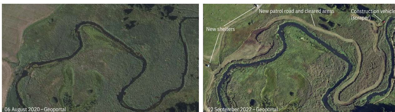
Figure 2.34. Construction of a patrol road along the riverine section of the Świsłocz (Svisloch) River, Podlaski Border Guard Division. Satellite imagery: Geoportal.gov.pl (Główny Urząd Geodezji i Kartografii), 2020/2022.
